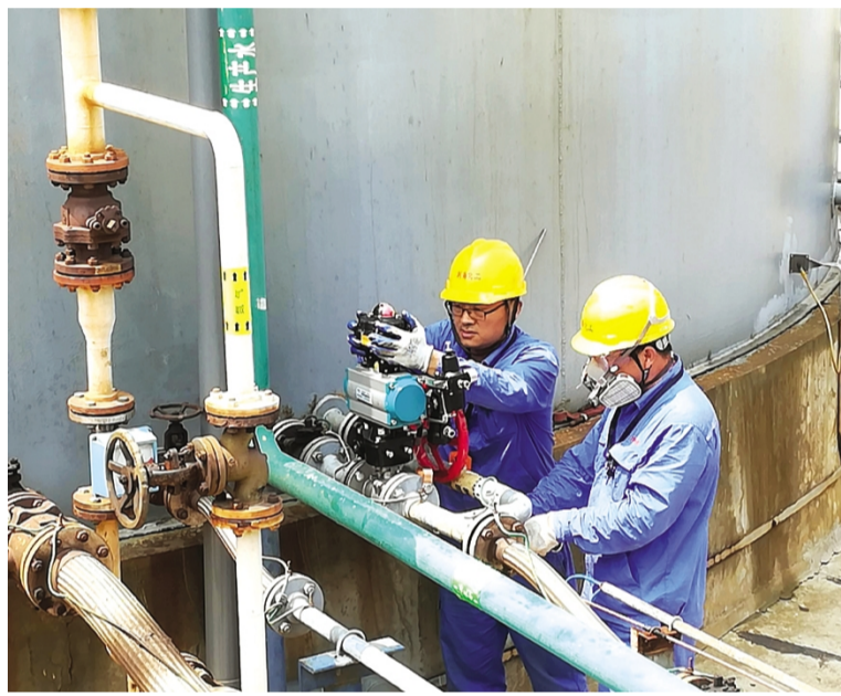
甲苯罐区是利海化工公司的重大危险源,为了加强对重大危险源监管力度,提升中控室对罐区实时远程监控管理水平,该公司对4个甲苯储罐出口加装紧急切断阀,为实施罐区24小时监控提供了有效保障。(张文)
